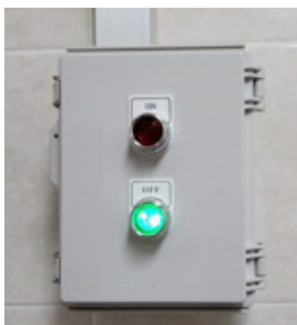
그림 3. D병원 음압 공조시스템 스위치
